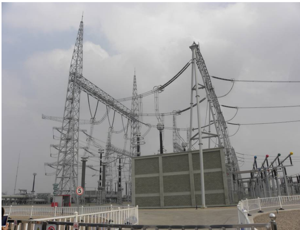
图 4.2-1 蒙西变电站站址现状
