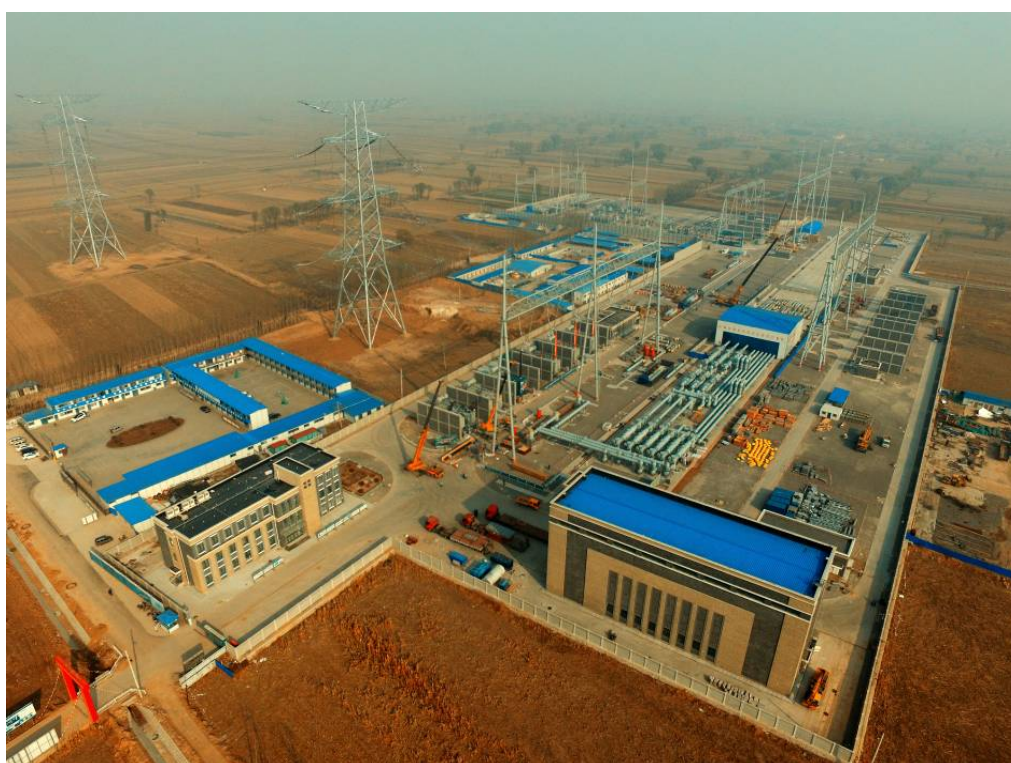
图 4.2-2 晋中变电站站址现状
