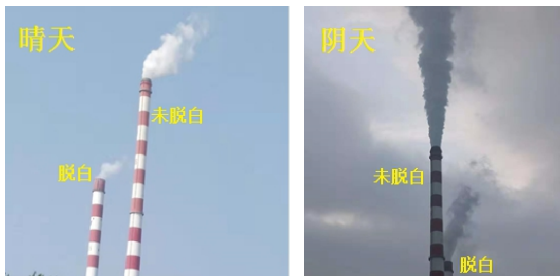
图 5 晴天和阴天下某电厂烟气黑度的观测
