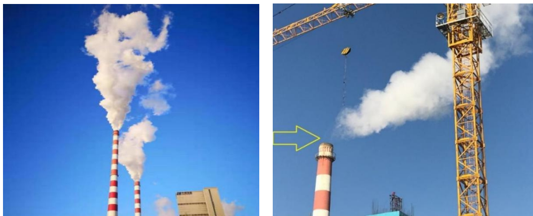
图9 有水汽的烟气观测位置的选取
