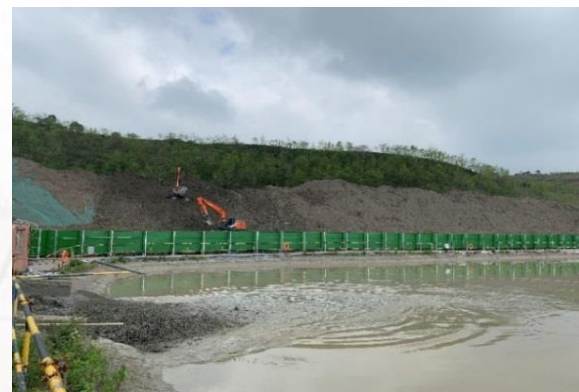
绍兴市城投再生资源公司泥浆消纳点
