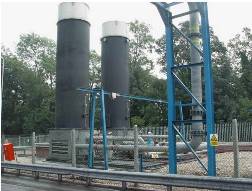
图4 瓦斯焚烧装置图
