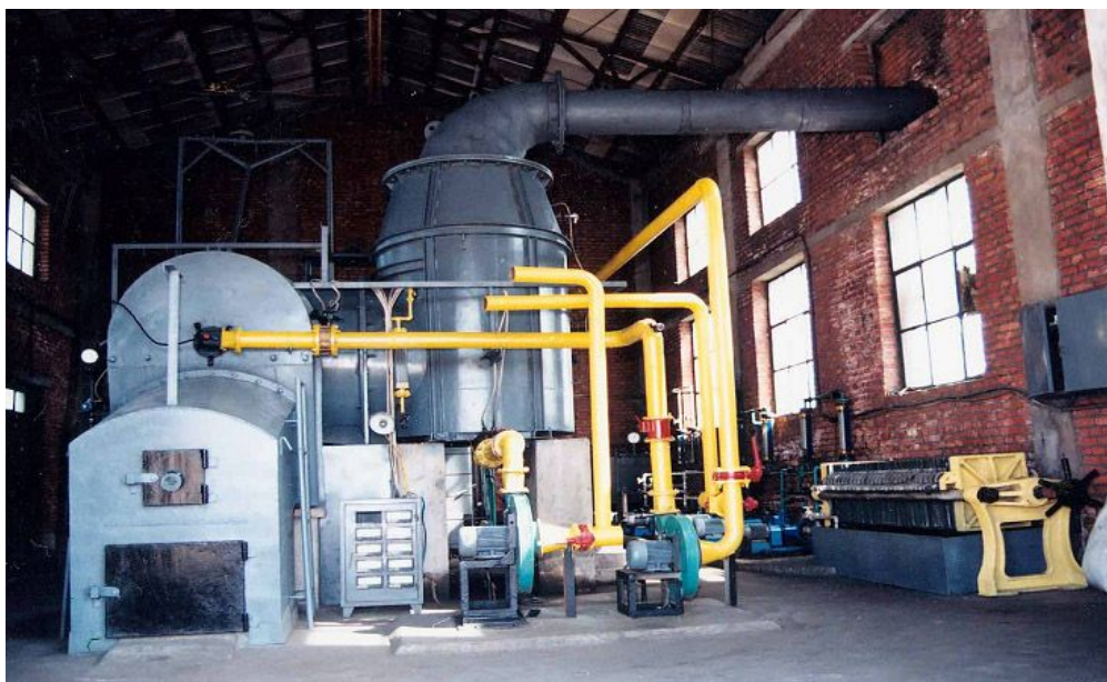
图 6.5 沈阳危险废物焚烧示范工程
