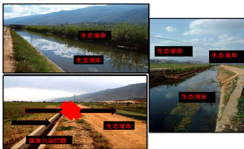
图4-29 生态护岸+截污沟技术
