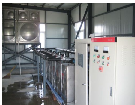
人工湿地配水控制室
