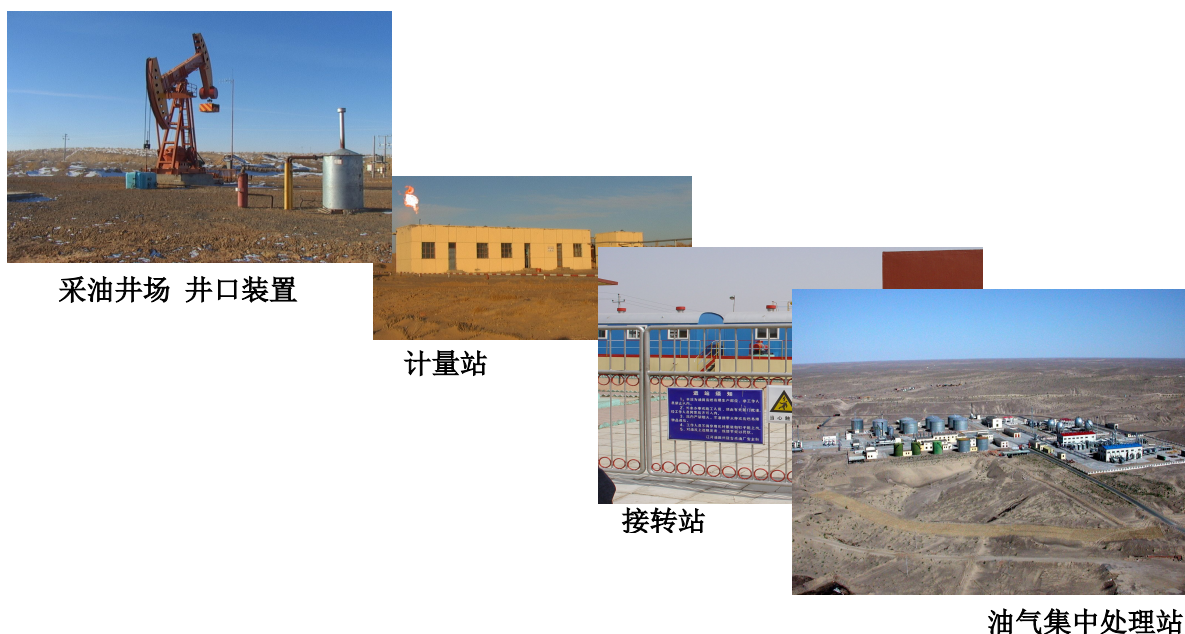
图 4-1 油气田主要生产设施
