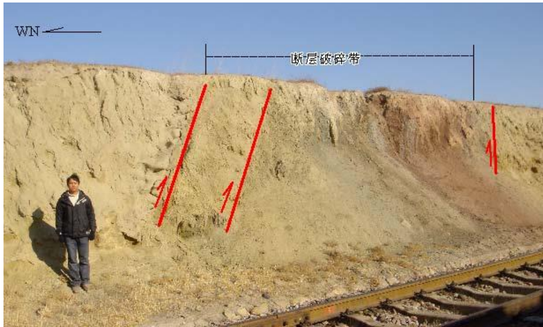
图 4.1-9 铁路路堑断层剖面(镜向北)
