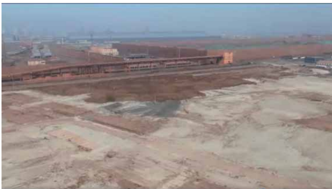
项目现场航拍照片
