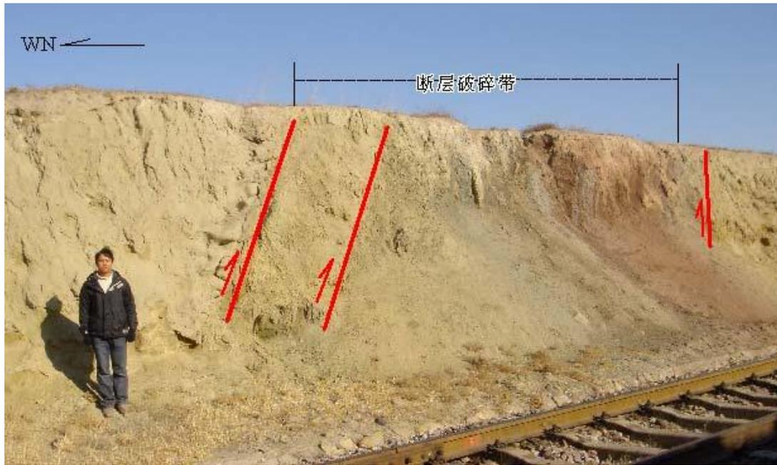
图 4.1-9 铁路路堑断层剖面(镜向北)
