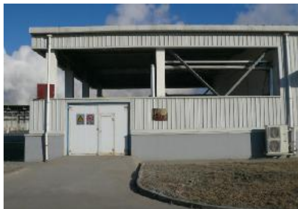
危险固废临时堆存库外观
