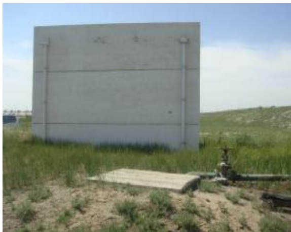
渗滤液收集池和渗滤液收集泵房
