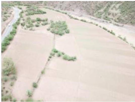
右岸上游存料场
