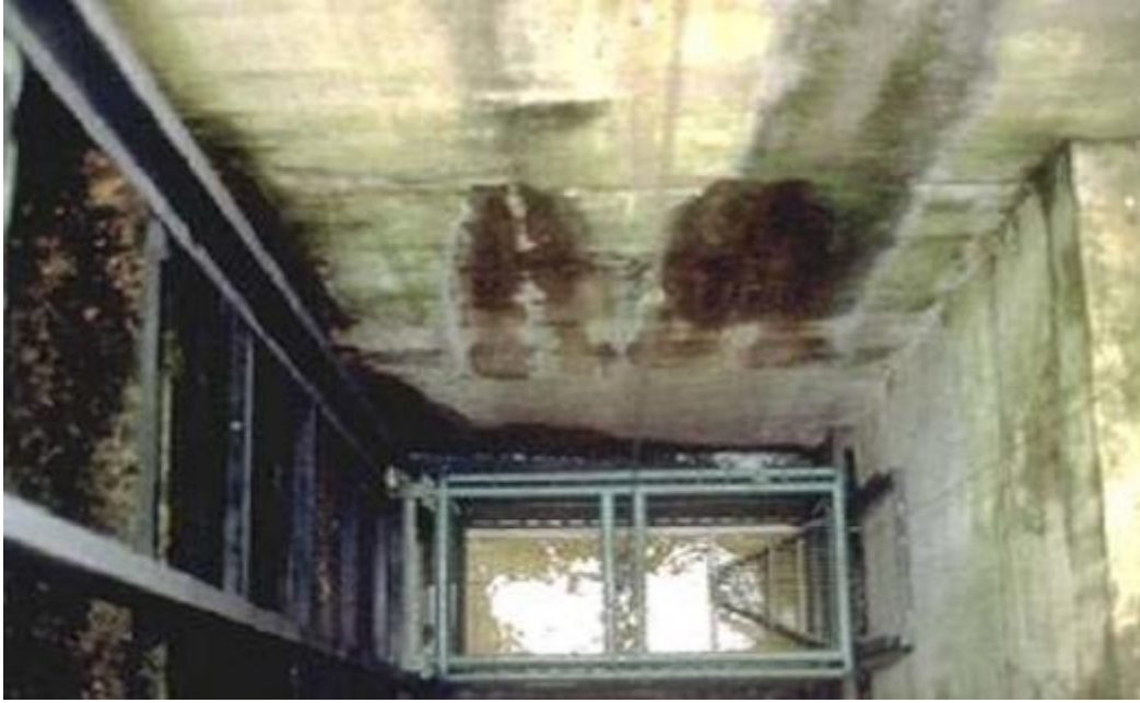
图 6.5.4-15 自带防逃笼型提升舱（法国 Poutes 大坝升鱼机）
