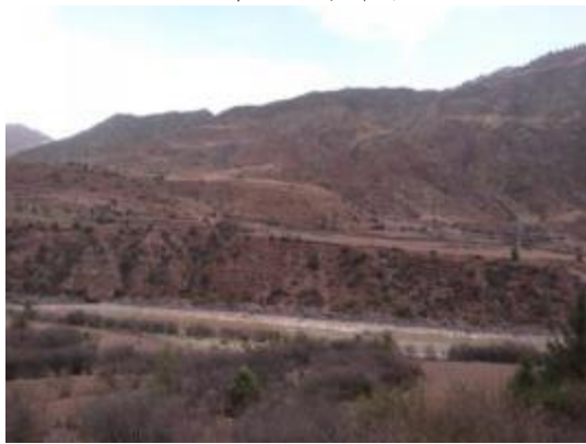
左岸上游2#存弃渣场
