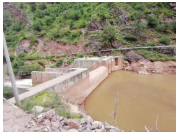
芒达曲下游已建小水电站
