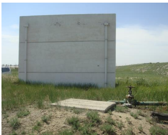
渗滤液收集池和渗滤液收集泵房
