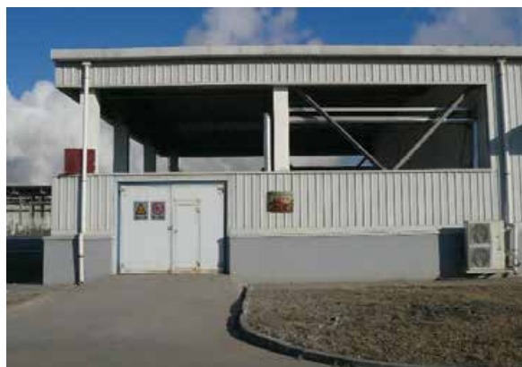
危险固废临时堆存库外观
