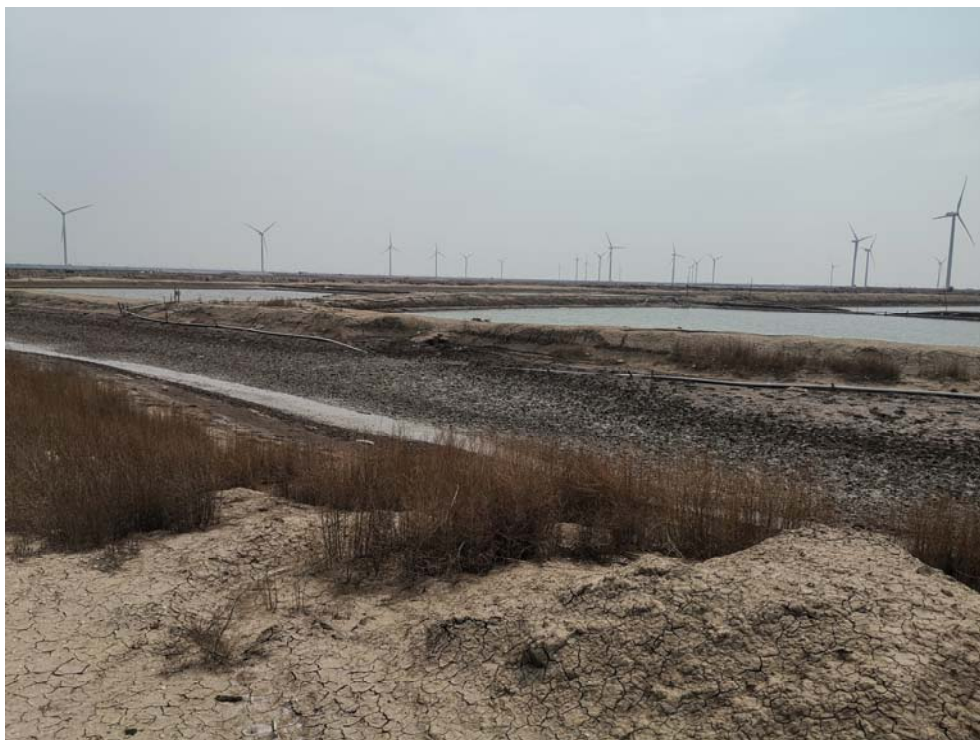
图 8.3-14 排水河定向钻入土点
