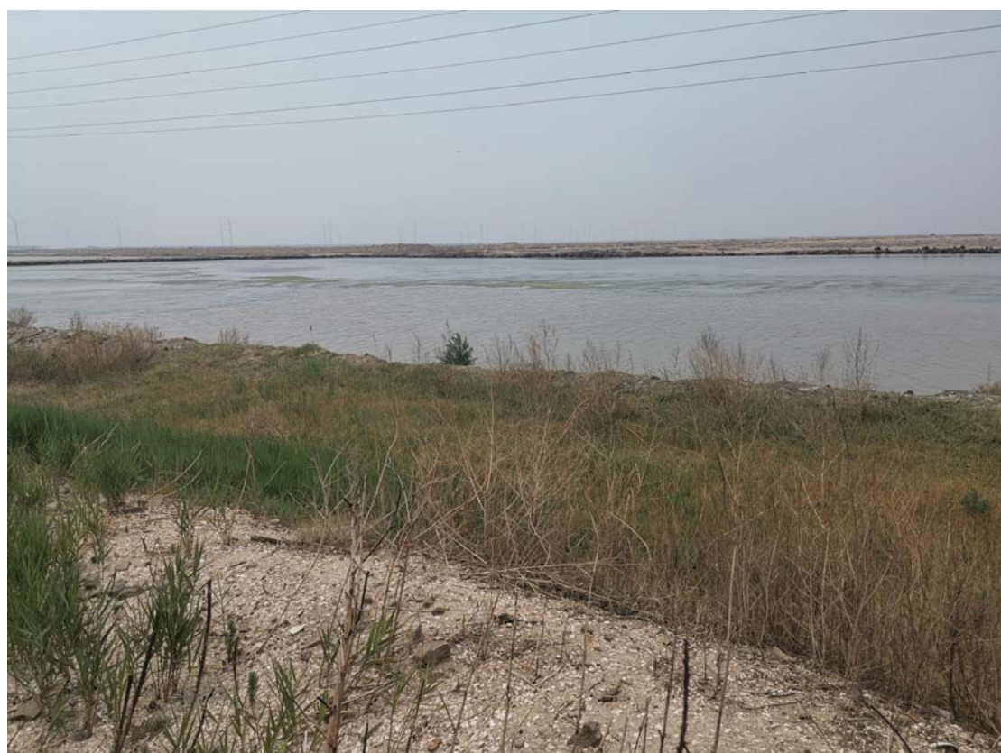
图 8.3-11 青静黄排水渠、子牙新河南岸入土点地貌图
