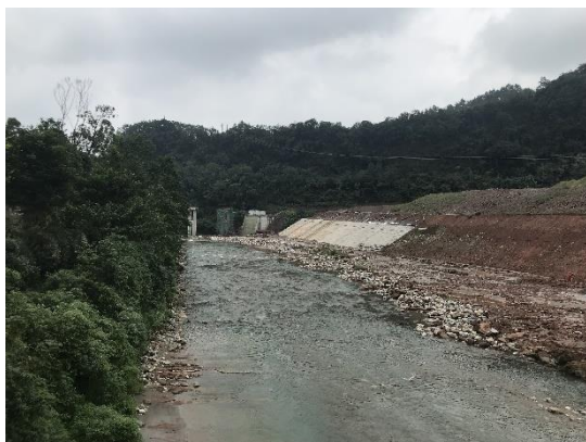
坝址下游永久交通桥
