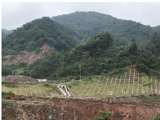
1#渣场边坡植物恢复
