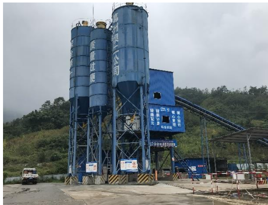
导流洞进口对岸混凝土拌和系统
