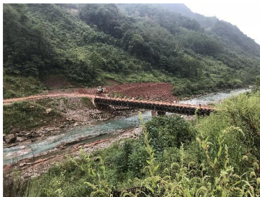
坝址上游钢栈桥
