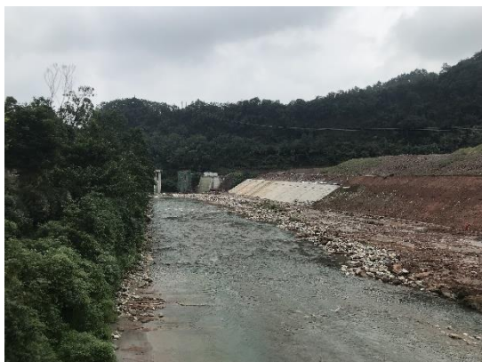
坝址下游永久交通桥
