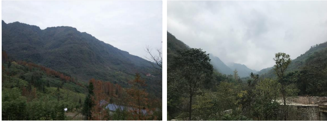
徐家槽料场现状
