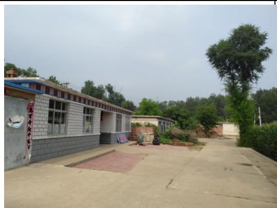
照片 1-3 关东营子 (线路穿越该村庄, 需拆迁 10 户)
