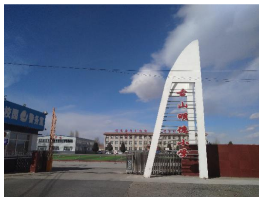
照片 2-8 古山明德小学 (平庄分输站/SW/1892)
