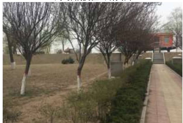
山东济南段大王庙引黄闸
