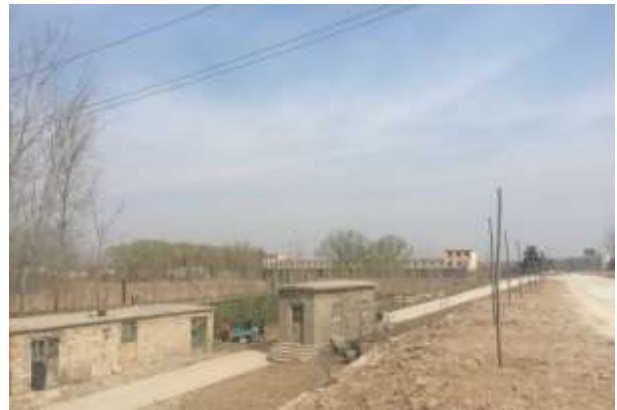
山东聊城段位山引黄闸
