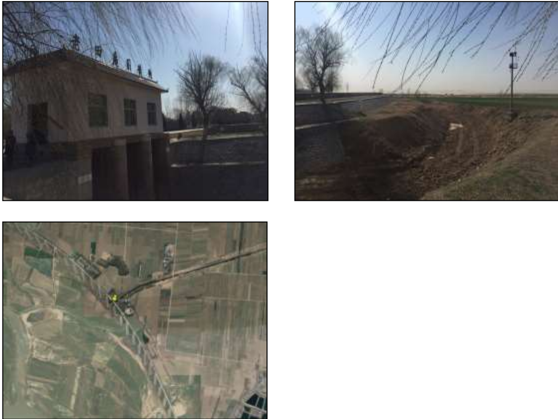
图 2.5-6 老田庵闸现状图
