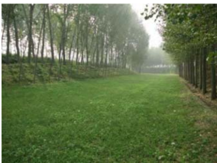
图 2-1-21 永北干渠渠槽
