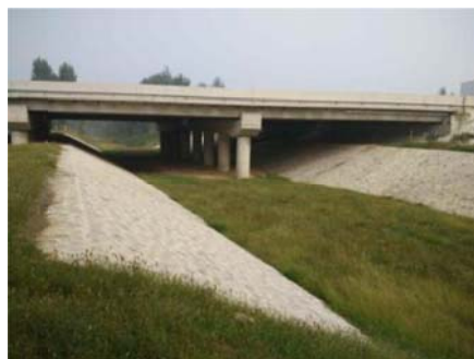
图 2-1-22 京台高速跨永北干渠中桥
