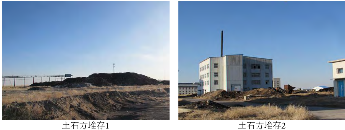
图3.6-1 工业场地土石方堆存现状
