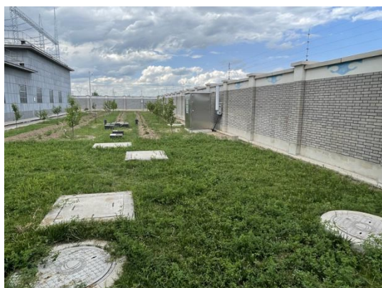
现有工程污水处理设施
