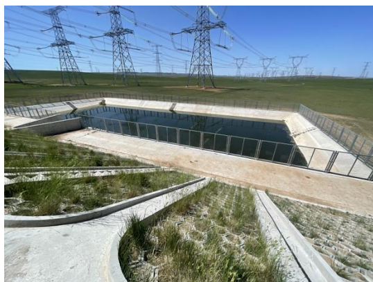
现有工程雨水蒸发池
