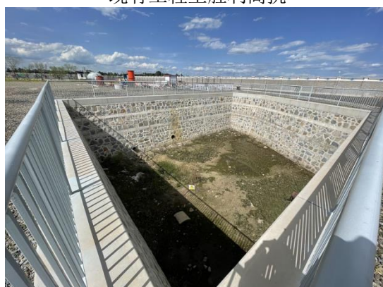
现有工程雨水蒸发池
