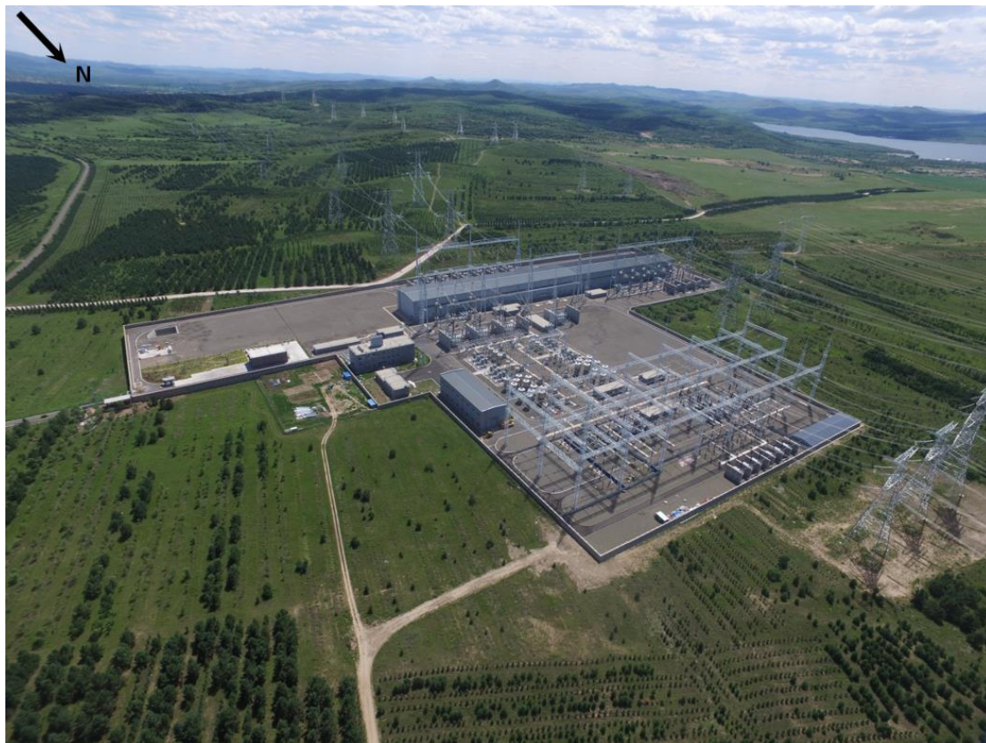
图 4.2-3 锡盟变电站现状
