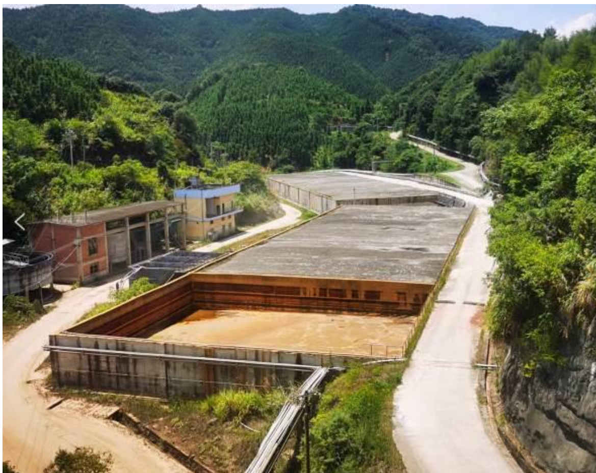
图 3.2-3 堆浸尾渣现状
