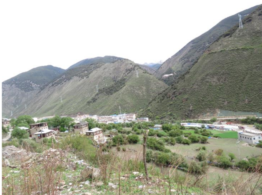
图 7-4 帮果换流站站址区域实景照
