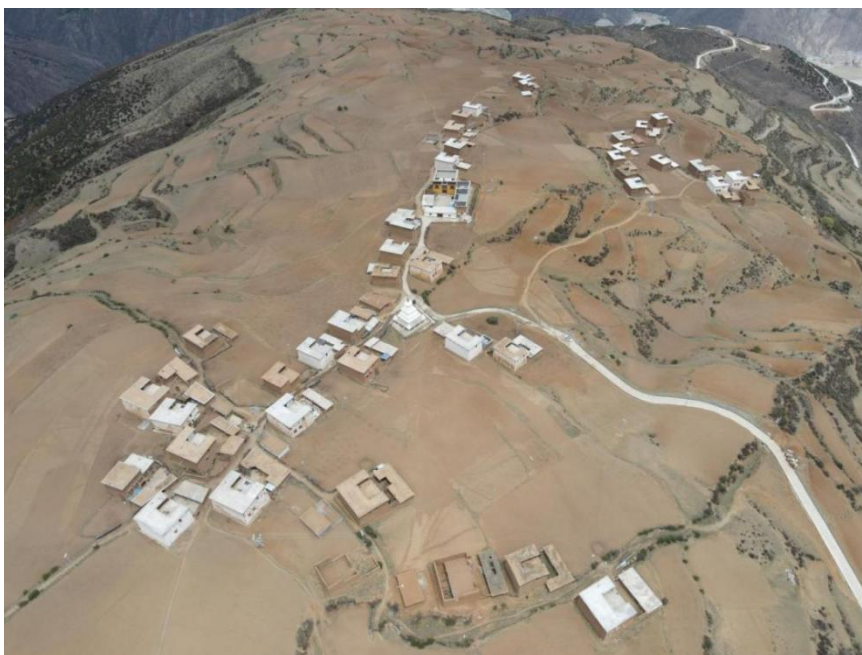
图 7-5 卡麦换流站站址区域实景照
