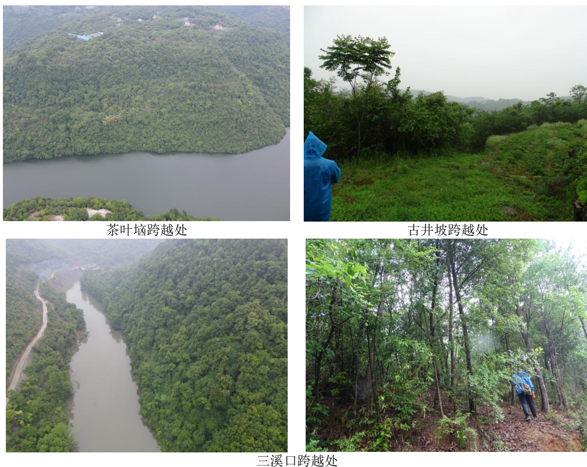
图 7-16 本工程线路跨越湖北宜都熊渡库区市级湿地自然保护区处生态环境现状
