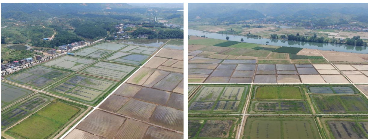
图 4-5 受端大桥铺接地极极现状及周边地貌
