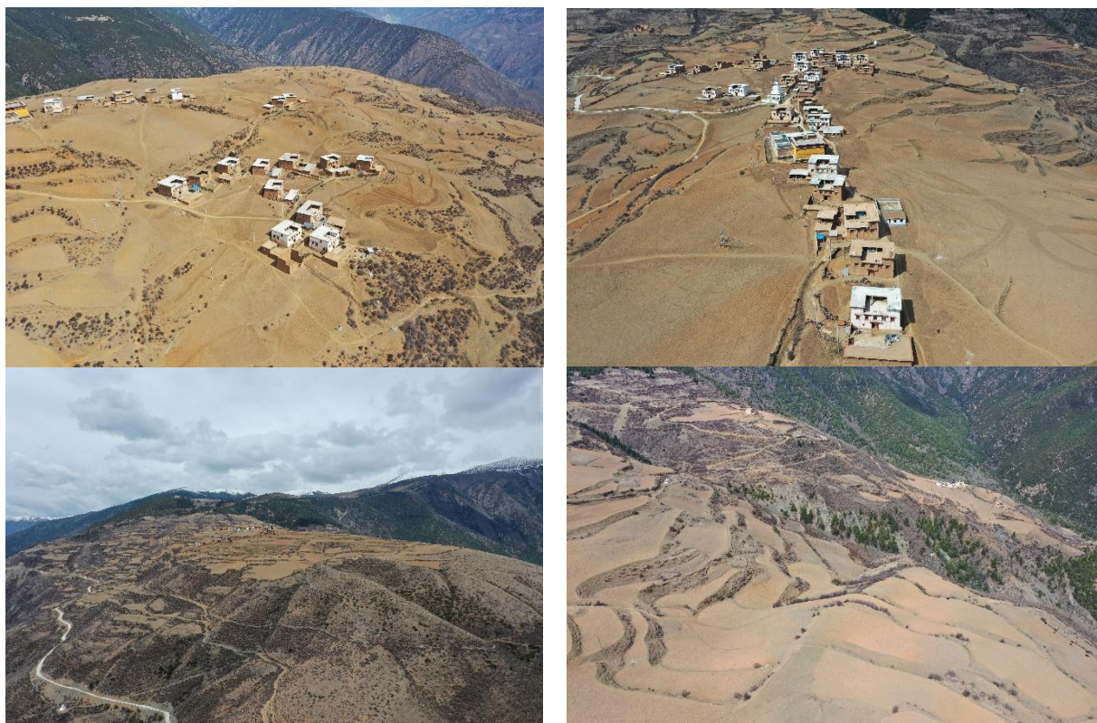
图 4-3 卡麦换流站站址现状及周边地貌
