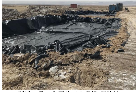
跃进二号工作区施工中现场-泥浆池
