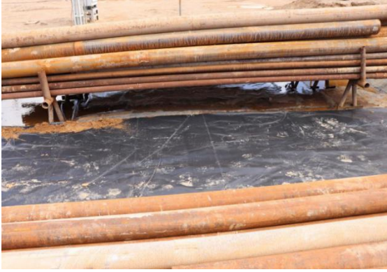
跃进二号工作区施工中现场-材料区
