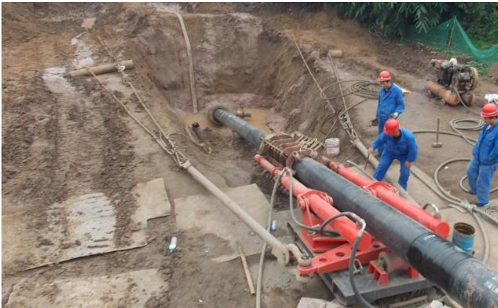
图 3.6-9 保护套管发送方式示意图
