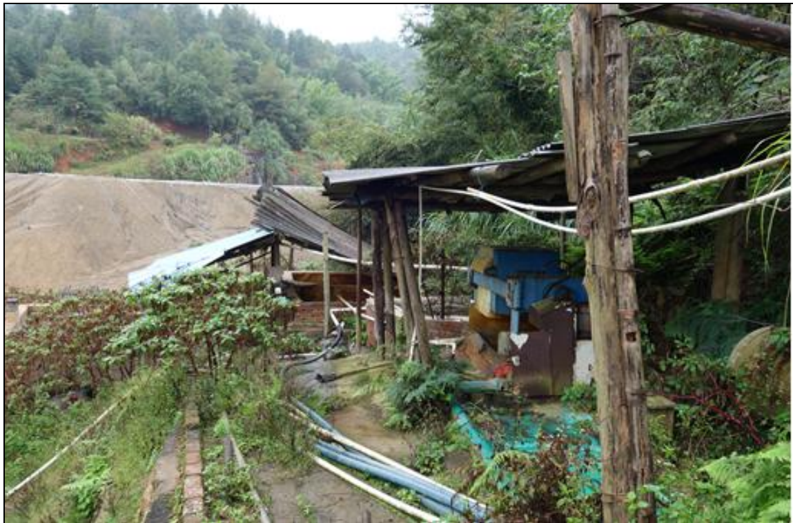
图 5.5-6 黄泥湖矿点遗留设备、管线现状
