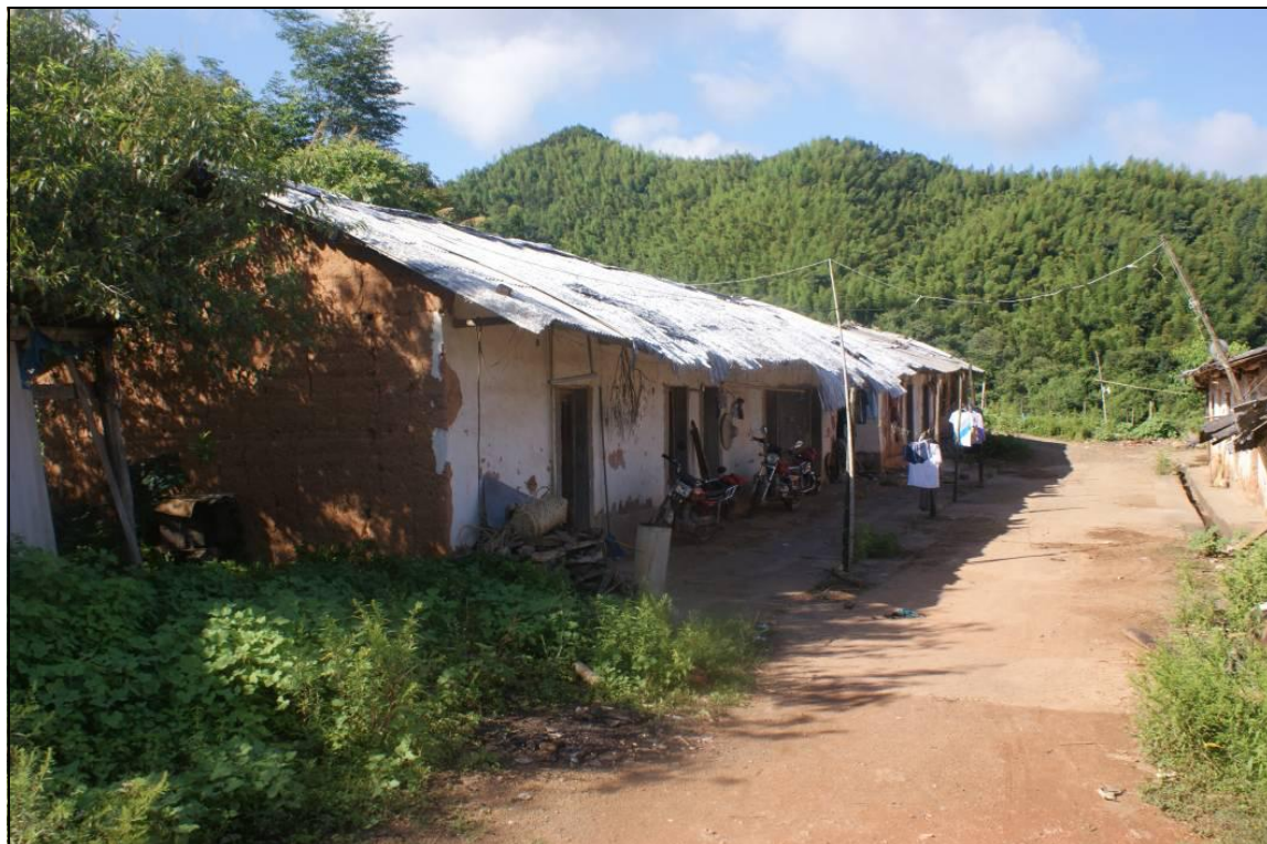
图 5.5-7 黄泥湖矿点遗留住房现状
