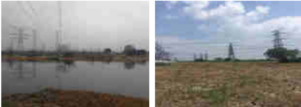
图 4-3 常熟换流站站址现状
