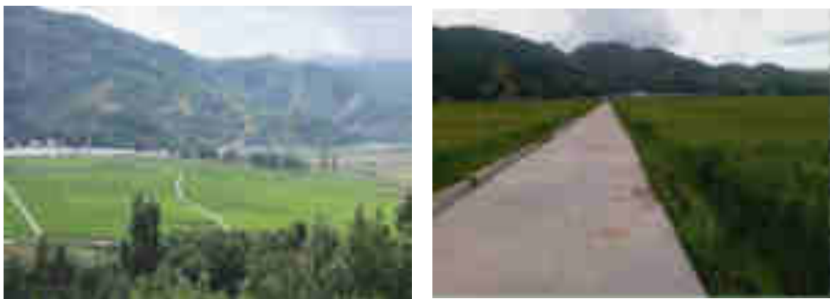
图 4-2 大坝接地极极址现状
