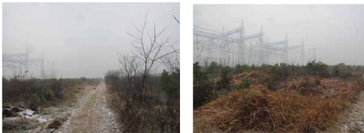
图 4-2 荆门变电站扩建端现状
