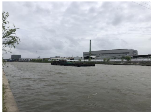
本工程改造后跨越处
