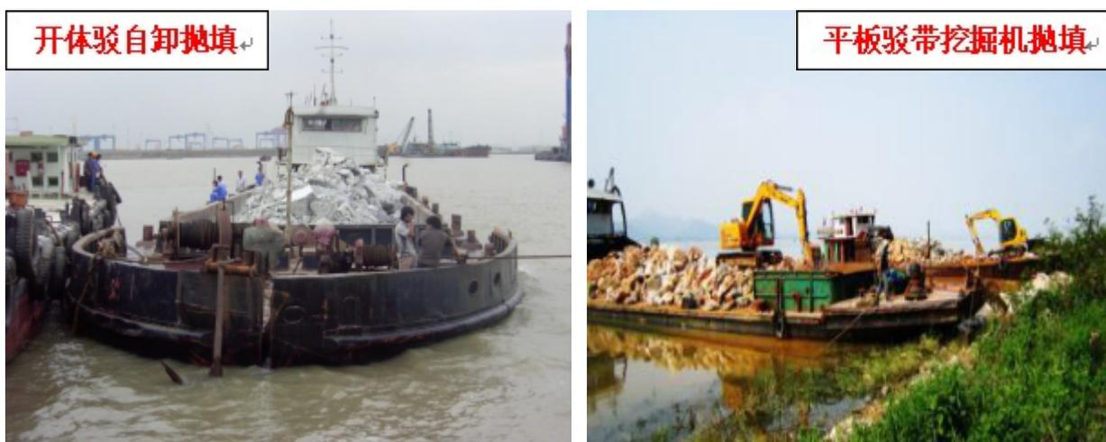
图 4.2-12 开体驳自卸抛填和平板驳带挖掘机抛填示意图
