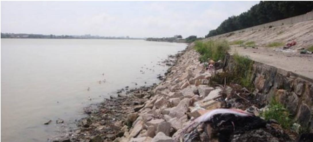
图 9.3-8 石材礁随机堆填布局效果图
