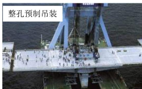
图 4.2-34 桥梁上部结构施工
