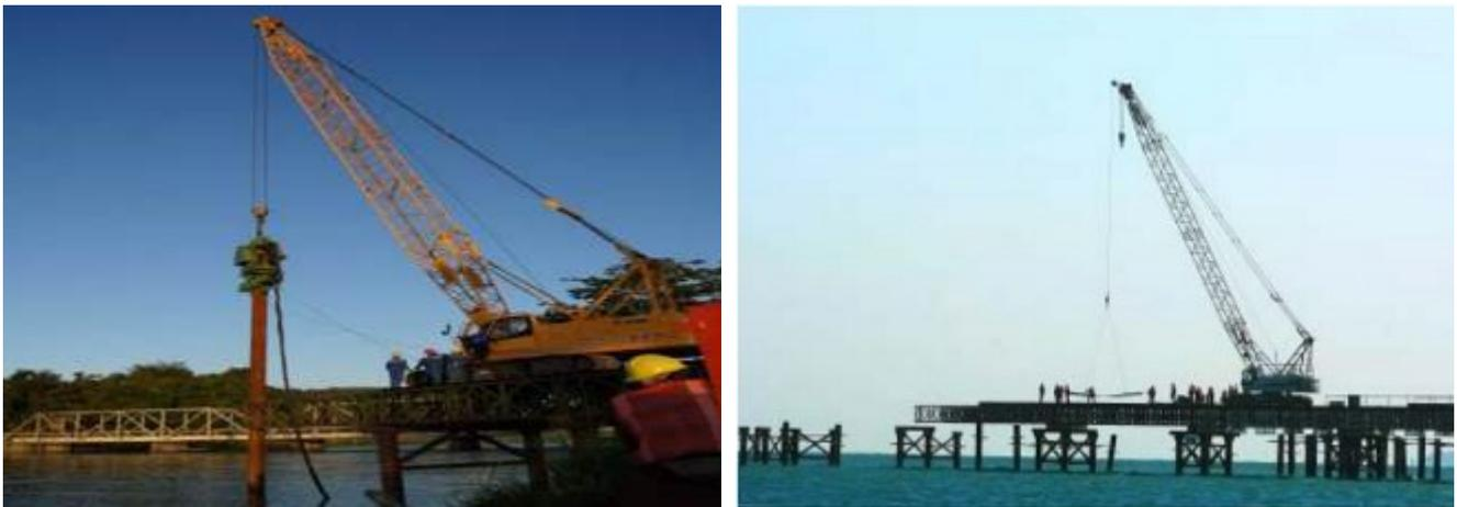
图 4.2-24 钢管桩栈桥示意图
