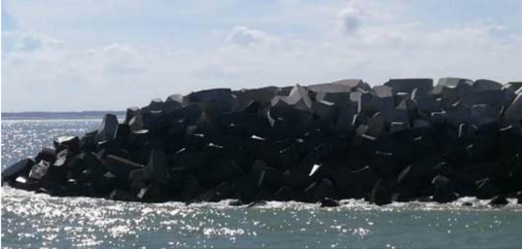
图 9.3-7 扭王字块混凝土礁随机安放布局效果图
