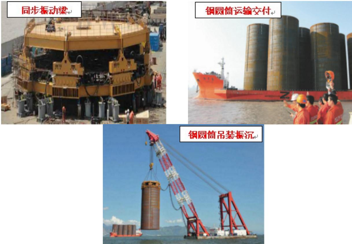
图 4.2-16 钢圆筒振沉示意图
