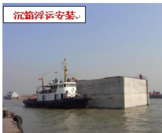
图 4.2-15 沉箱半潜驳出运河沉箱浮运安装示意图
