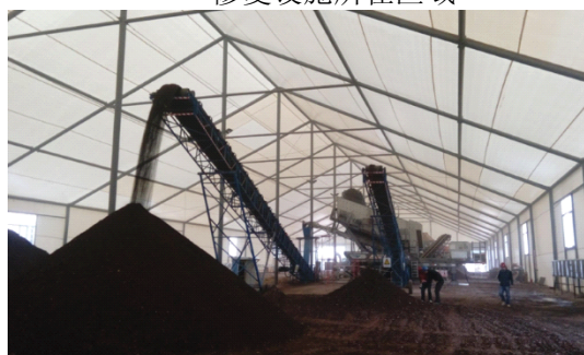
修复设施内部
