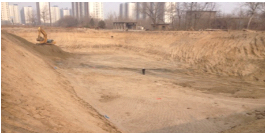
图 7 10 异位清理遗留基坑照片
