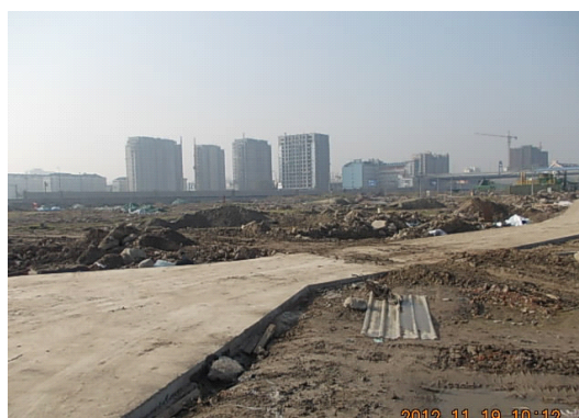
修复场地临时道路
