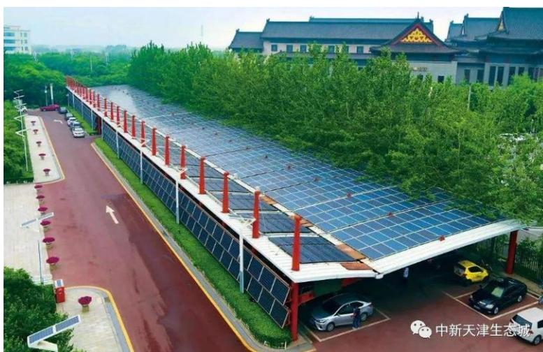
图 35 生态城服务中心光伏停车场实景图
