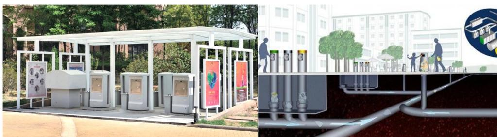
图 5：生态城居住区的气力输送系统
