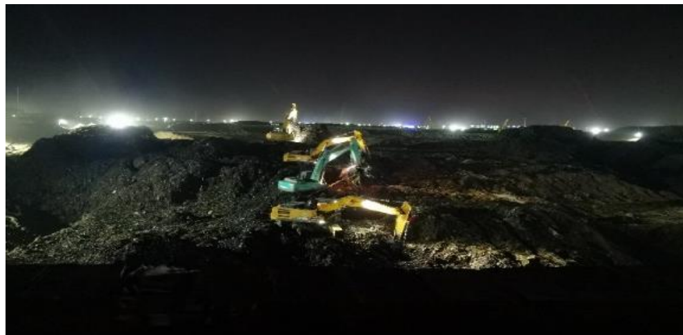
容城县垃圾填埋场垃圾开挖晾晒
