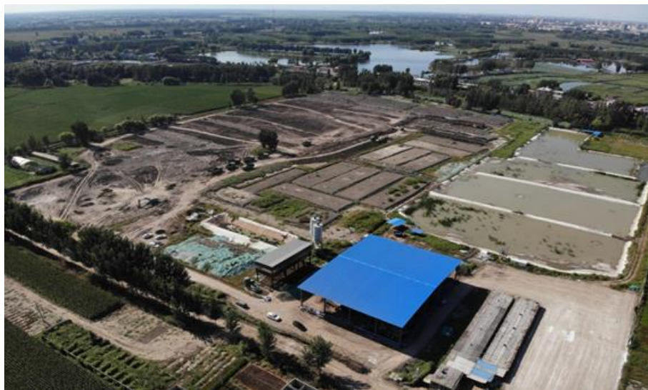
白洋淀清淤底泥资源化利用场
