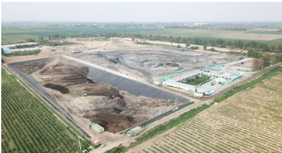
铝灰钢渣资源化储存场（总规模59.5万立方米）
