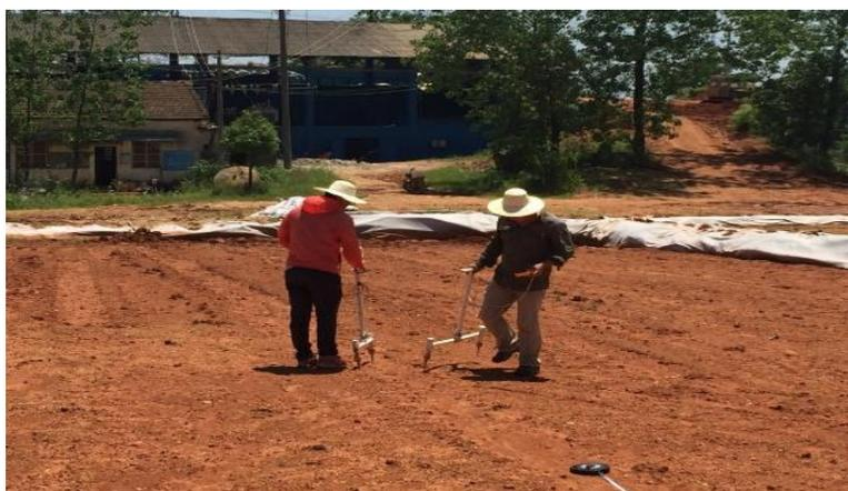
图 5.1 某堆浸场防渗层完整性检测
