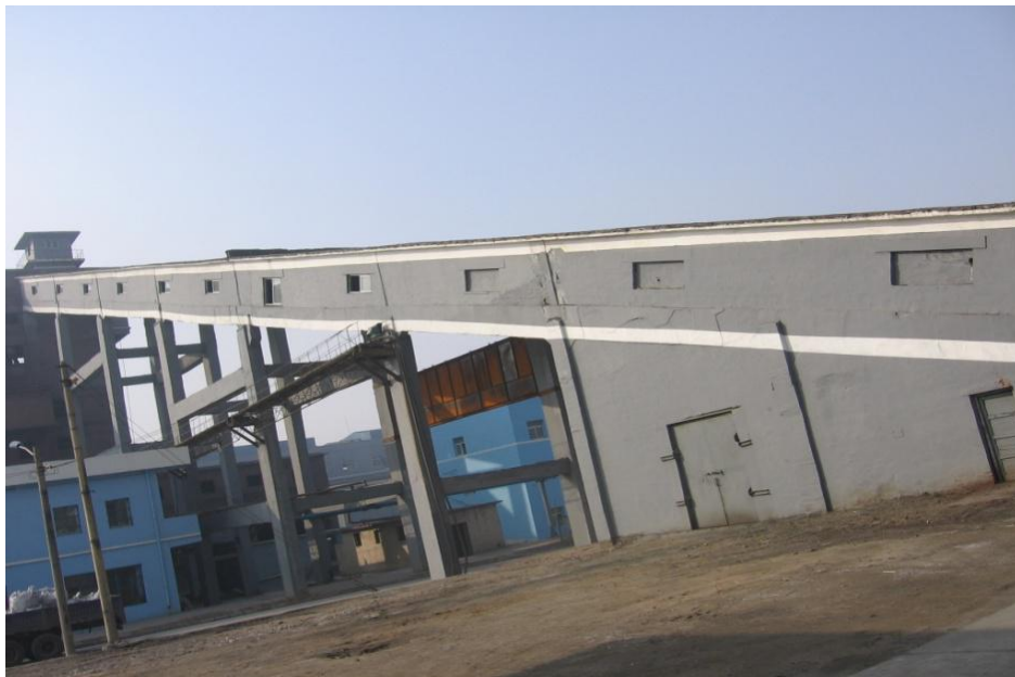
图 3 铜冶炼原料输送皮带廊
