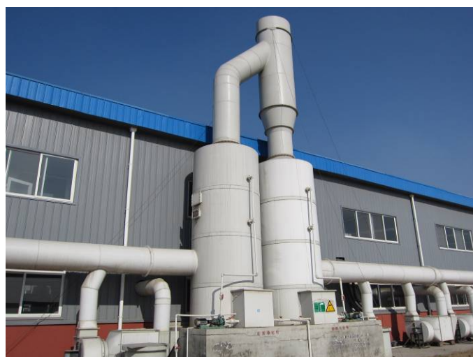
图 17 硫酸雾净化器
